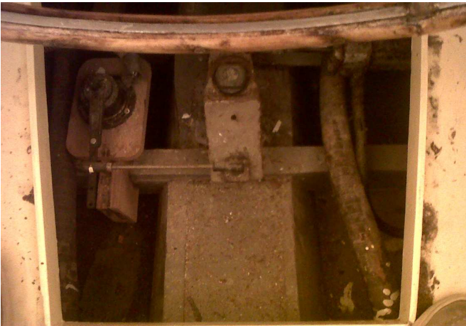
Timoneria con sistema idraulico, il braccetto dell'asse è collegato all'angolo di barra ed al pistone idraulico che fa anche da autopilota.
