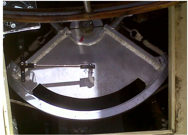
Timoneria con sistema a frenelli, il settore include anche il braccetto per il pistone dell'autopilota e l'attacco del sensore dell'angolo di barra.
